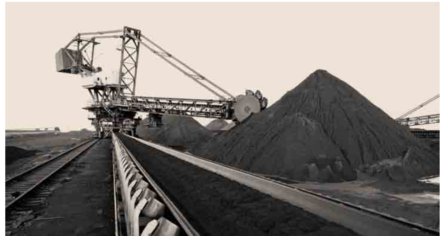
Pátio de estocagem de minério de ferro do Porto de Tubarão, em Vitória (ES), Brasil, em 1972. Foto: Arquivo Jornal da Vale.
